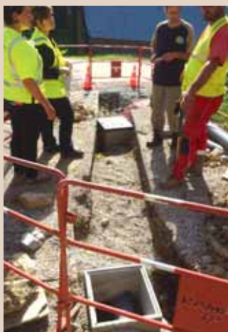
La Morte, mise en séparatif
